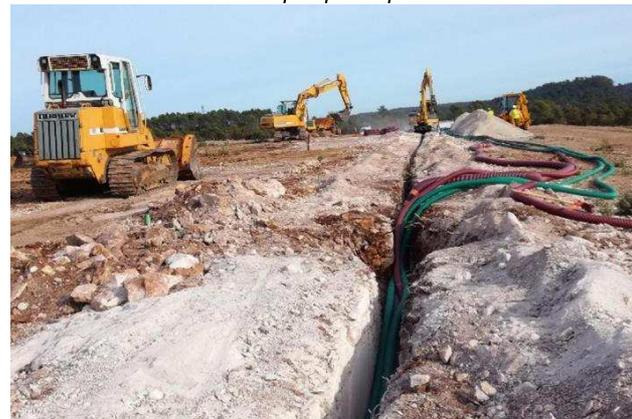
*Réalisation des tranchées et installation des câbles*
